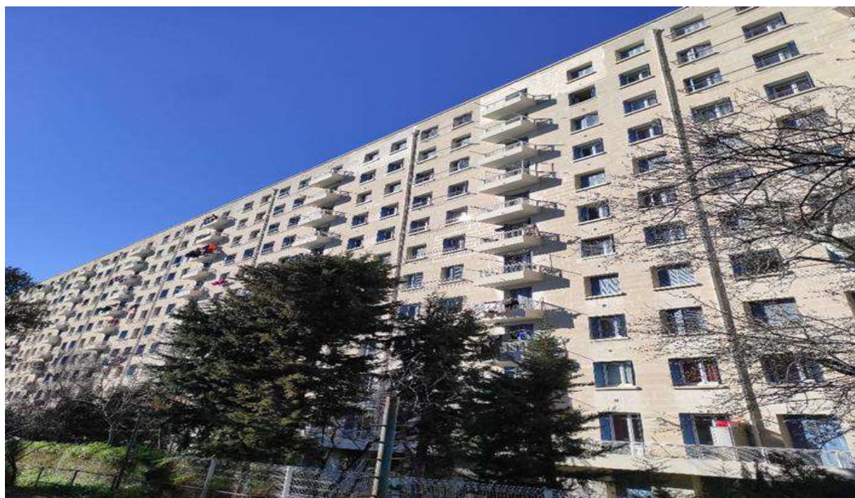
Photo : ROBERT Florentin, Bâtiment Hopkinson. 14/02/2025
