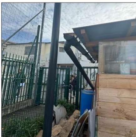
Une gouttière permet de récupérer l'eau pluviale du toit du cabanon à outil et alimente un petit réservoir.
