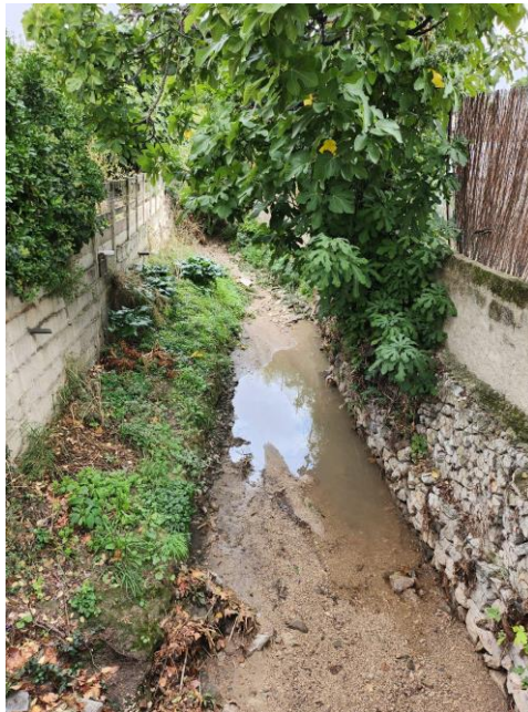
Figure 34 : Photo prise à Plan-de-Cuques le 24/10, le Jarret est bordé sur ses deux rives par des maisons desquelles il est séparé par un mur
