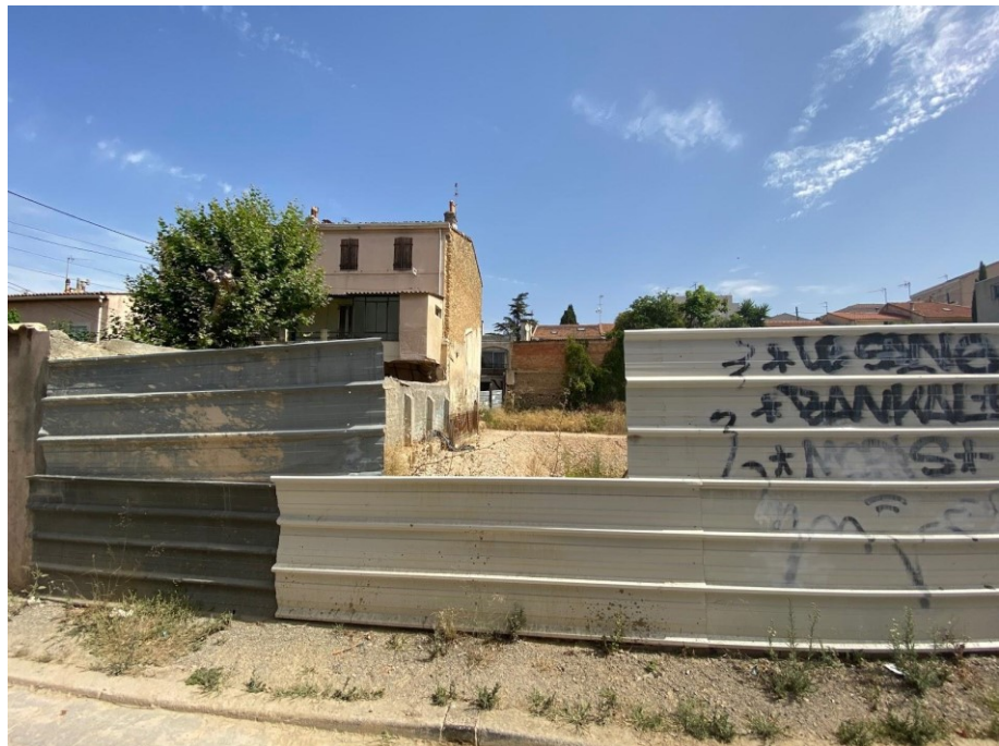
Photo 2: espace cloisonné par des tôles en acier (espace semi-clos) 18/07/2023 (Ferlat C)
