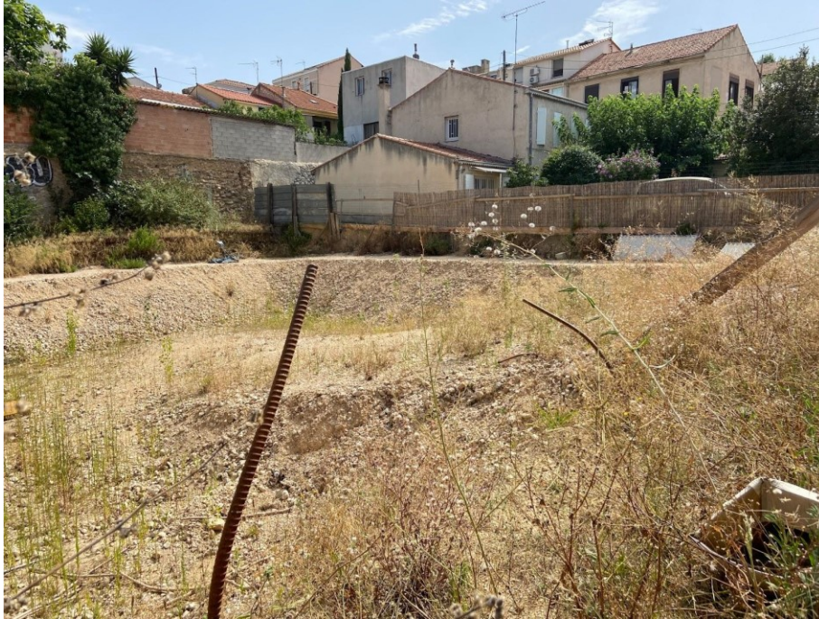
Photo 1: terrain privé vierge creusé (en chantier?) 18/07/2023 (Ferlat.C)
